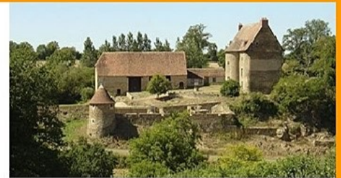
XIV e siècle : la maison-forte du Sazeray (Indre)
