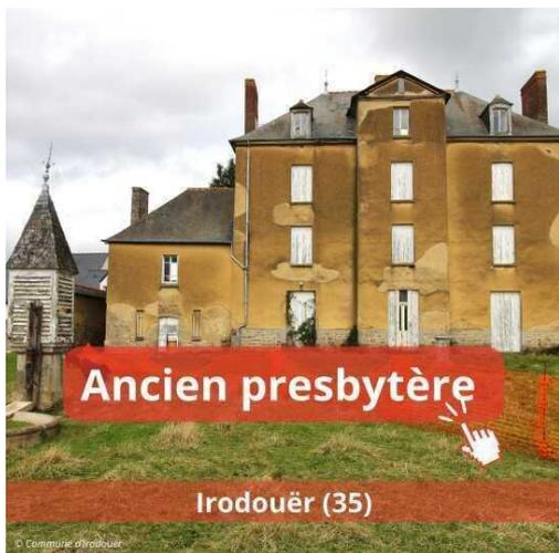
L'ancien presbytère d'Irodouër est le plus haut bâtiment en bauge en Bretagne construit dans la seconde moitié du XIX<sup>e</sup> siècle. La bauge nécessitant un travail laborieux soumis à un savoir-faire technique et à un temps de séchage donne à cette construction sur 3 niveaux une dimension architecturale exceptionnelle. La commune d'Irodouër souhaite restaurer l'édifice et lui donner une nouvelle vie au cœur de la commune.
